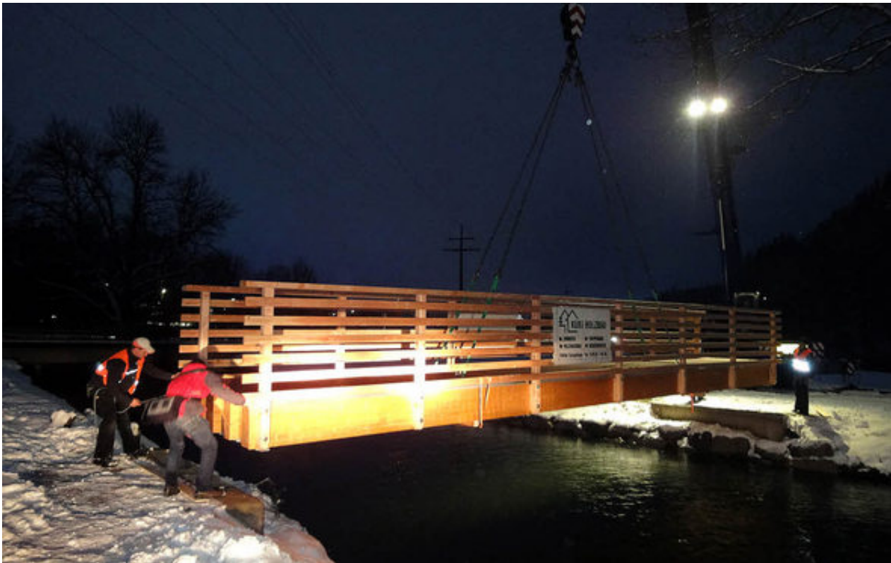
Passt, wackelt und hat Luft: Fachleute montieren bei Flutlicht die neue Holzbrücke. Foto: silke hartenstein
